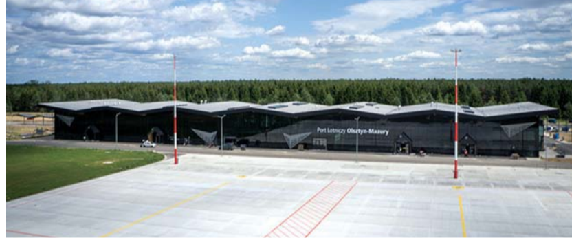
Terminal od strony płyty lotniska
