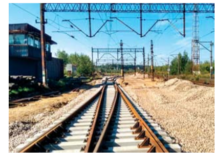
W ramach zadania wymienionych zostanie m.in. 19 rozjazdów
