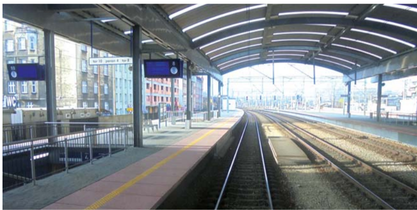
Wyremontowane perony i tory na dworcu w Katowicach
